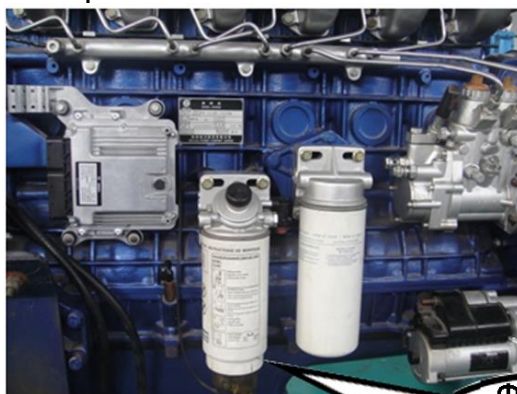
Фильтр предварительной очистка топлива
